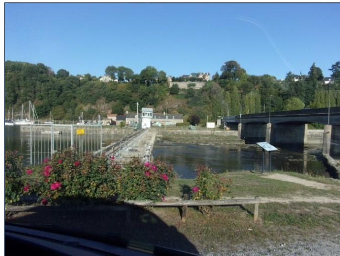
Figure 9: L'écluse du Châtelier, regard de la rive droite ; Photographie : M2 ETP, 10/2019
