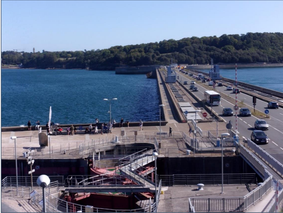
Figure 23 : Barrage marémoteur ; Photographie : M2 ETP, 10/2019
