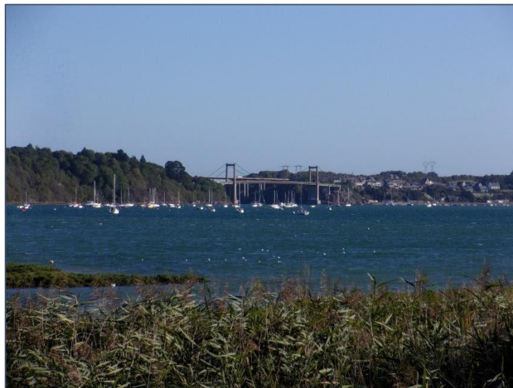
Figure 14: Vue sur le pont Saint-Hubert ; Photographie : M2 ETP, 10/2019
