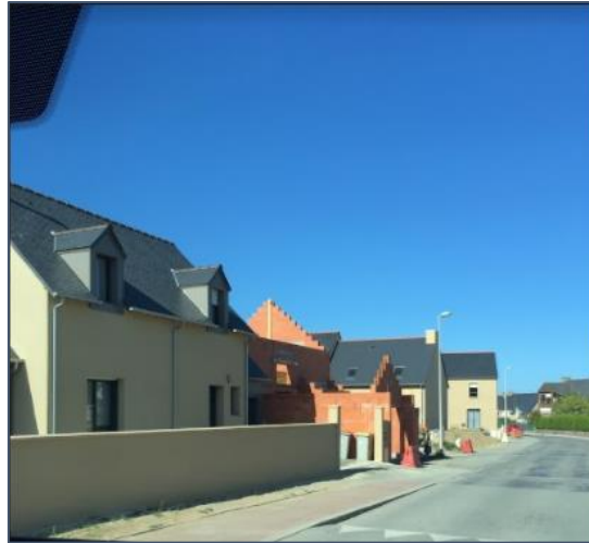
Figure 31 : Des maisons en construction à Saint-Jouan-des-Guérets ; Photographie : M2 ETP, 10/2019
