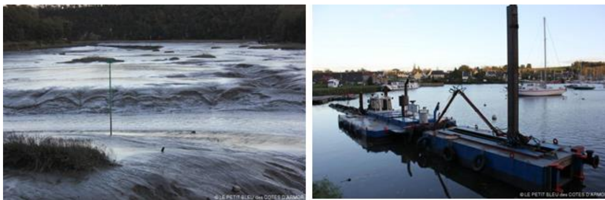
Figure 76 : A gauche le piège de Lyvet rempli, à droite le système d'aspiro-dragage des sédiments
